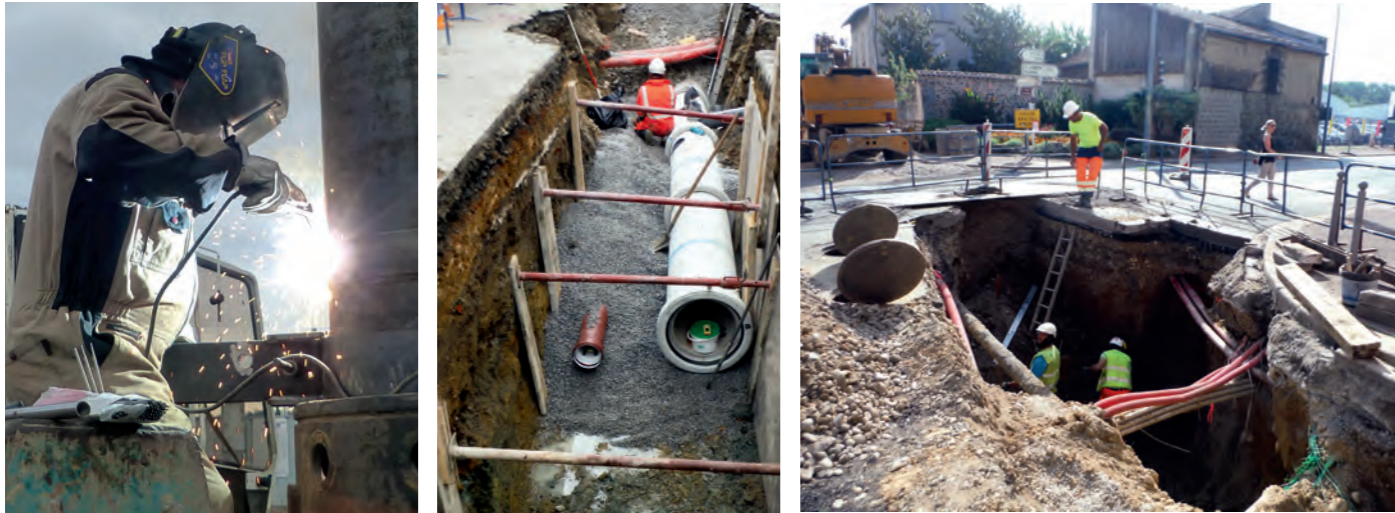
Préparation du gainage d'un des 4 puits d'infiltration des eaux pluviales sur le parvis du parking de la gare à Brignais. Mise en séparatif des réseaux d'eaux pluviales sur les communes d'Orliénas et Loire-sur-Rhône.
